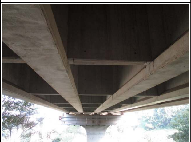
거더 및 가로보
